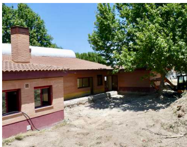
Obras de la futura comisaría.
